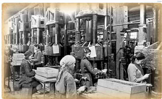
**Завод «Электросигнал»** за годы войны обеспечил средствами радиосвязи каждый самолёт и каждый третий танк. Кроме производства радиоизделий, завод в военный период осуществлял выпуск финских ножей, гранат, а также хвостовой части самолетов в помощь соседнему авиационному предприятию.
